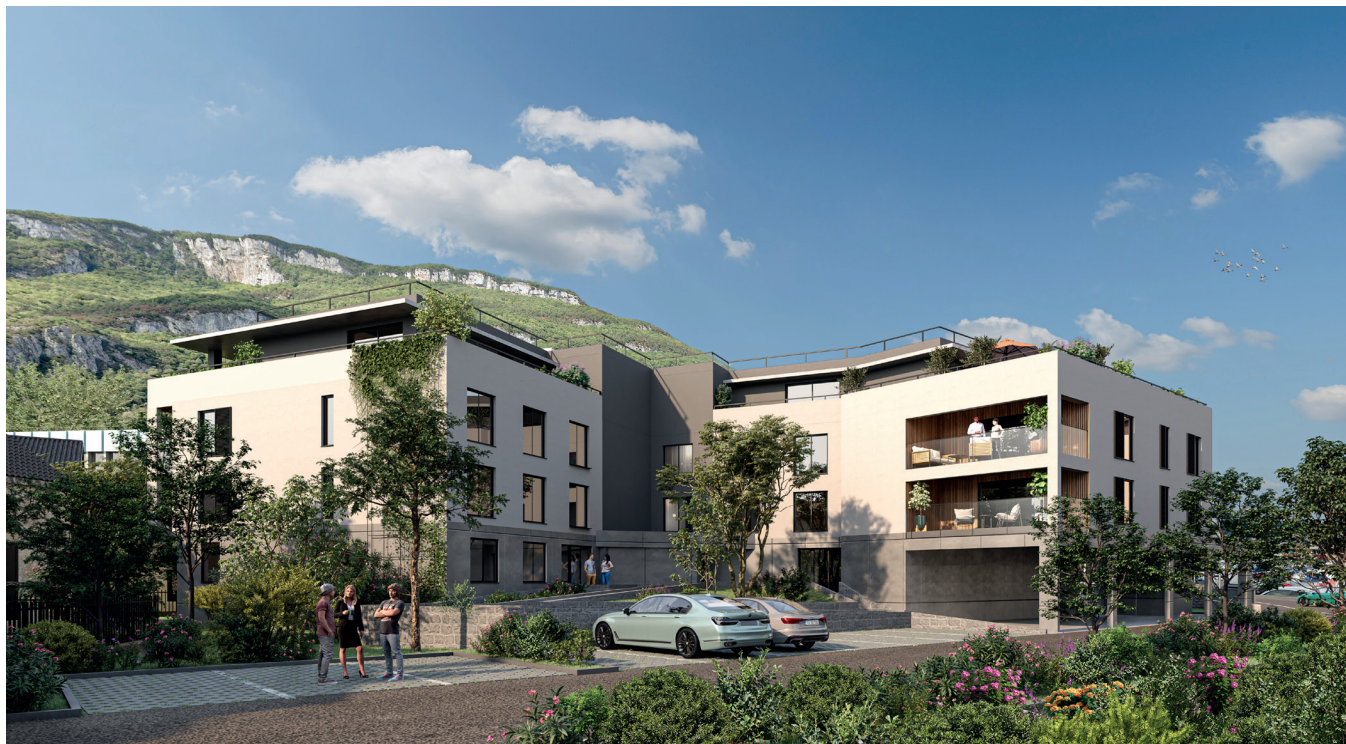
SASSENAGE, 11 chemin des pies, NESTOR
